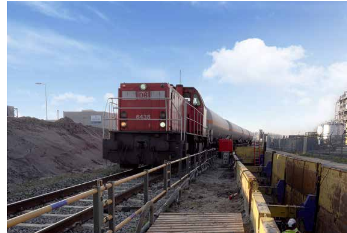
In opdracht van netbeheerder Stedin heeft SGS Roos+Bijl de directievoering op zich genomen voor het aanpassen en verleggen van een grote hoeveelheid cruciale kabels en leidingen in de ondergrond.
