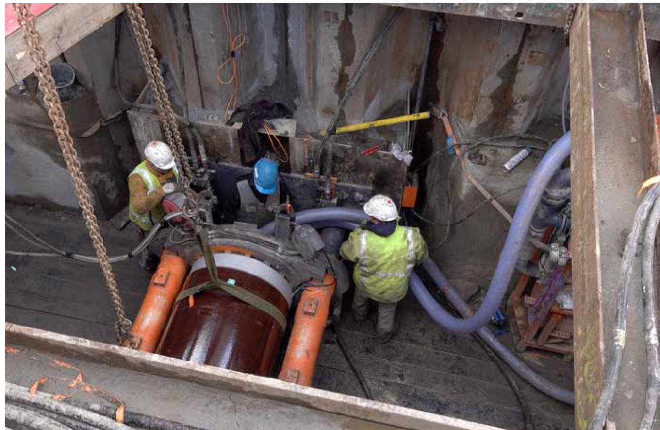
SGS stond ook in voor het ontwerp en de coördinatie van een vijftal tunnelboringen vanaf het hoogspanningsstation onder de rijbaan en het spoor door.
