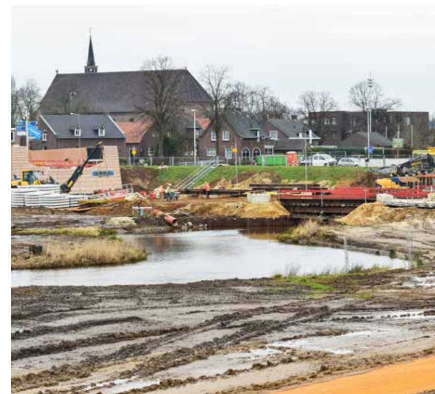
Aanleg van de nieuwe brug, de verbinding tussen de twee dorpskernen van Wanssum.
