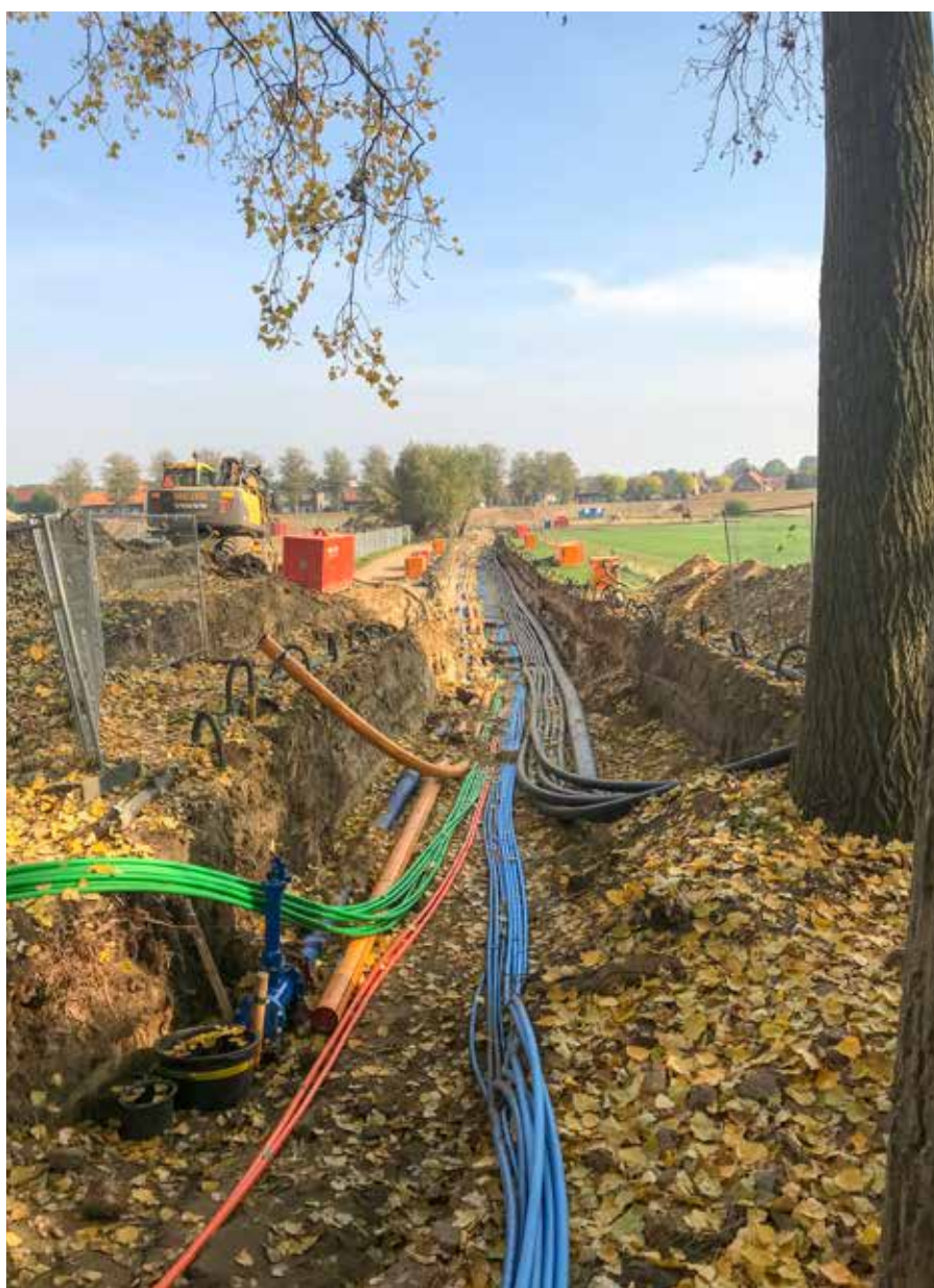
Verlegging van alle disciplines kabels en leidingen middels één grote sleuf.
