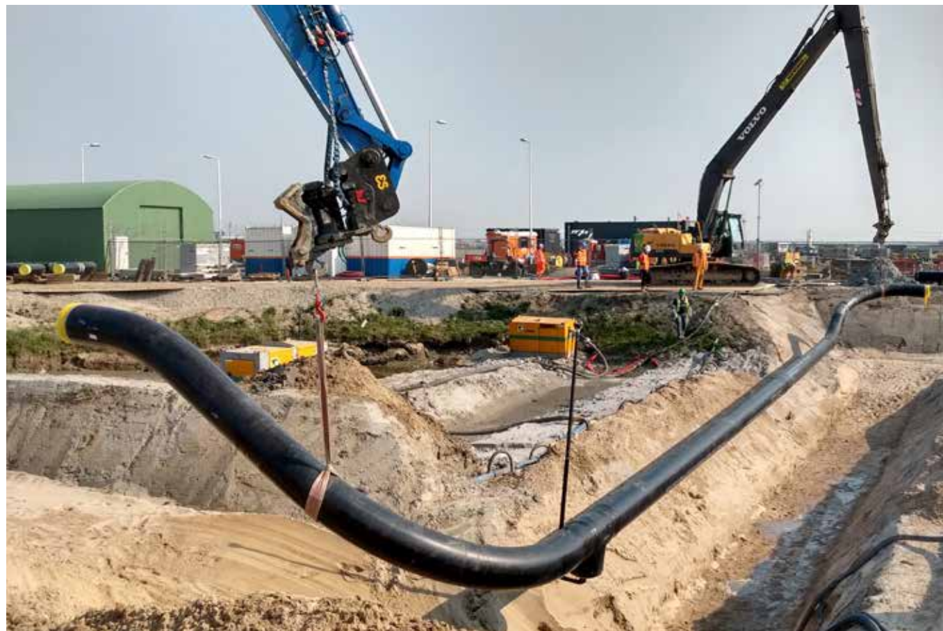
Zinker onder nieuwe watergang door waarvoor een uitgebreide sterkteberekening is gemaakt.
